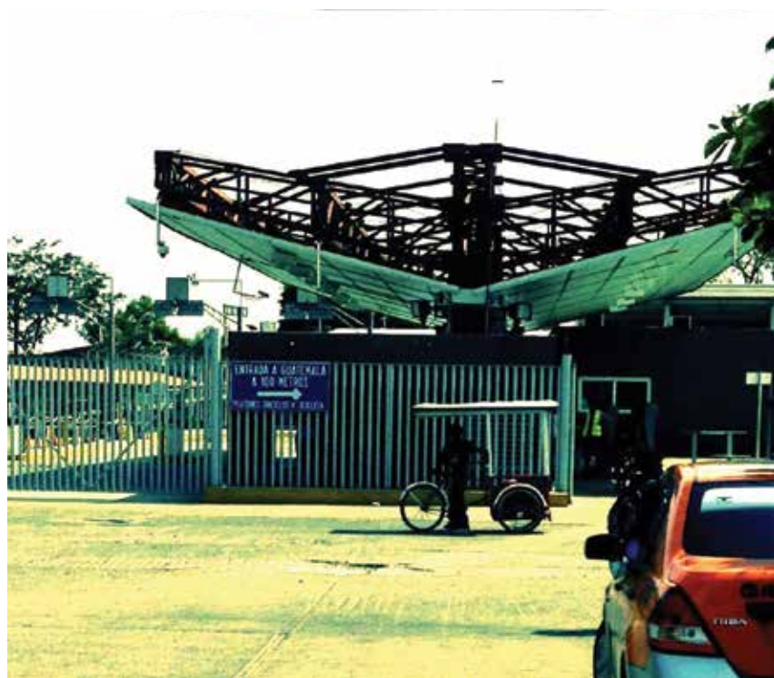
Instalación recientemente construida en la ciudad Hidalgo, México. Nuevos quioscos biométricos están dentro.
